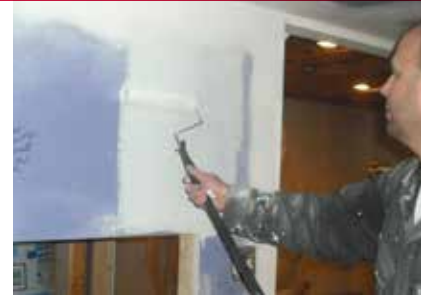
Applying primer to new drywall.
